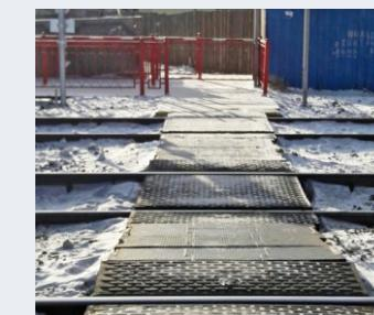
Настилы обладают противоскользящей поверхностью и обеспечивают безопасность перехода в любую погоду.
